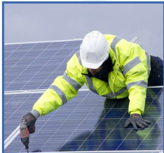
Instalación de módulos fotovoltaicos Jinko 460W
